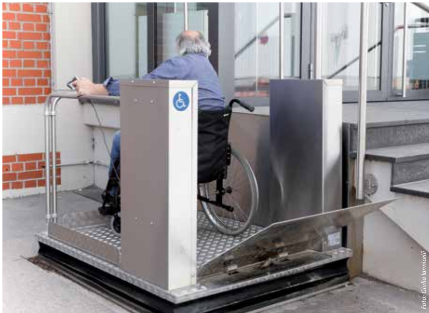
Zum Erreichen der Kantine wurde ein Hublift installiert.
